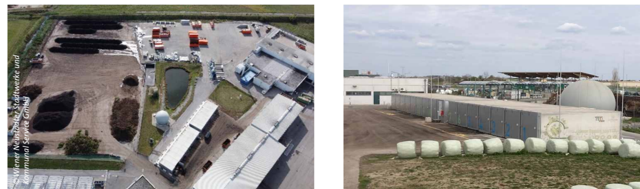
Abb. 3-6: Biogas- und Kompostanlage Wr. Neustadt
