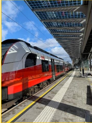
Abbildung 11 - PV-Bahnsteigüberdachung ÖBB Wien-Matzleinsdorferplatz, Foto: Architekturbüro Reinberg ZT GmbH
