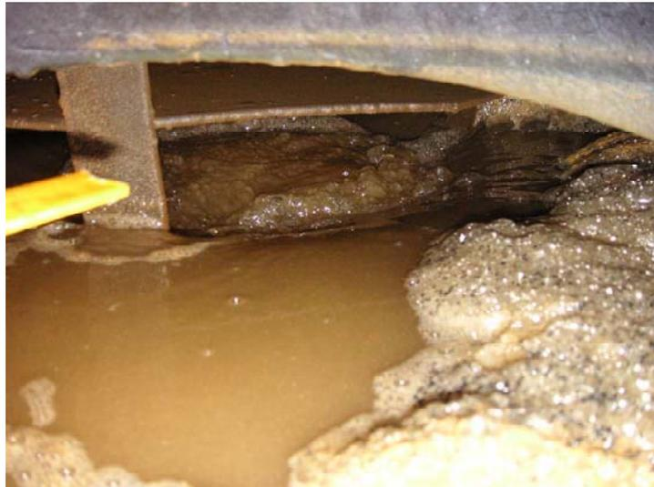
**Abbildung 3: Filter I, Überlauf bei einer Spülwassermenge von ca. 90 m<sup>3</sup>/h**
