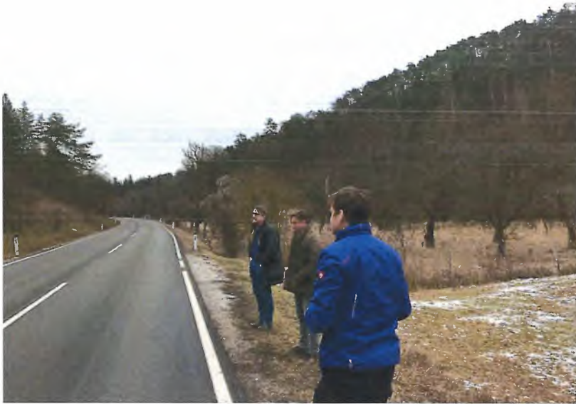
Abb.1 Talboden des zukünftig geplanten Hochwasserschutzdammes bzw. Rückhaltebeckens
