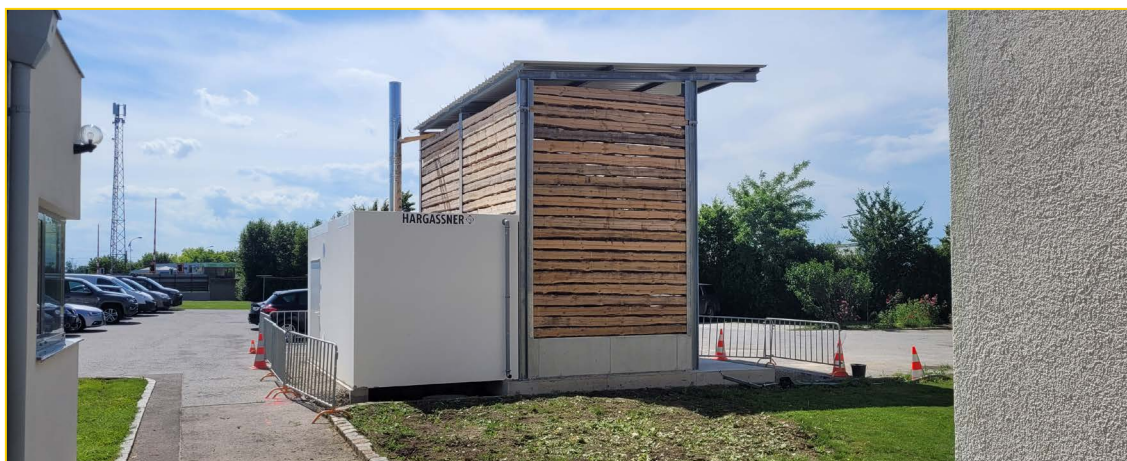
Hackgutlager der Straßenmeisterei Bruck/Leitha
