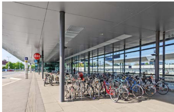
Direkt am Bahnsteigzugang platzierte Bike&Ride-Anlage
