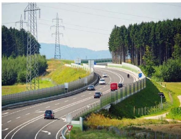
Dreistreifiger Straßenquerschnitt (2+1-Querschnitt), der abwechselnd für jeweils eine Fahrtrichtung einen Überholstreifen aufweist
