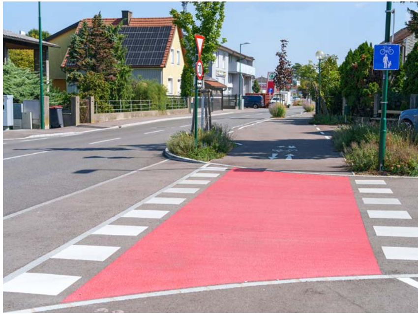
Radfahrerüberfahrt im Zuge eines Radweges
