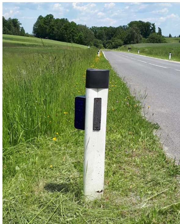
Leitpflock mit seitlich montiertem Wildwarner
