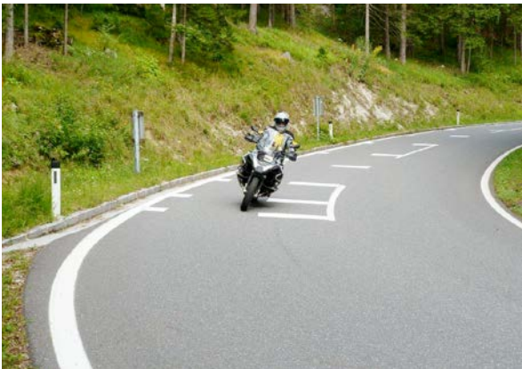
Kennzeichnung einer engen Kurve durch Leitwinkel und Absicherung der Leitschiene durch einen Unterfahrschutz
