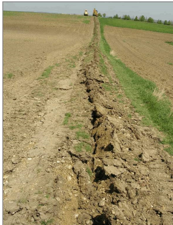
Pflugverlegung: Der Eingriff ist vergleichsweise gering
