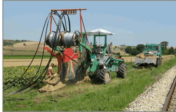
Pflug-Tross: Verpflügung mit ausgelegten Kabeln
