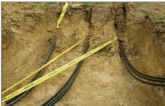
Übergang Pflugverlegung - Künette
