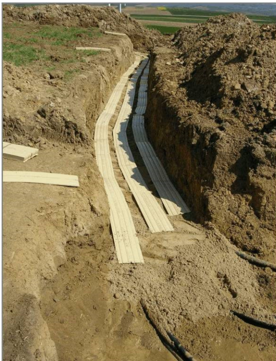
Verlegung durch Graben einer Künette
