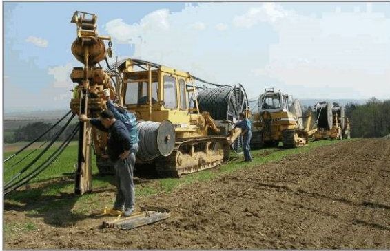
Pflug-Tross: Verpflügung direkt von den Kabeltrommeln
