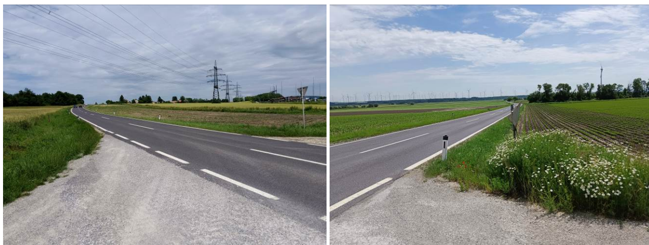
Abbildung: Sichtverhältnisse von Westen kommend, nördliche Ausfahrt auf die B 211 – Blickrichtung Nord (li.) und Süd (re.)
