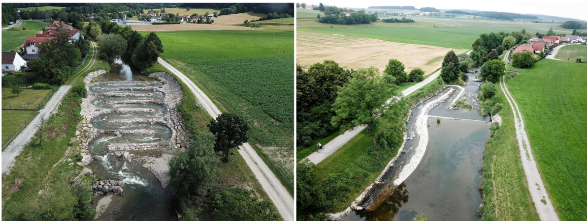
Abbildung 4: Zwei Fischwanderhilfen am Michelbach mit vergleichbarer Bauweise
